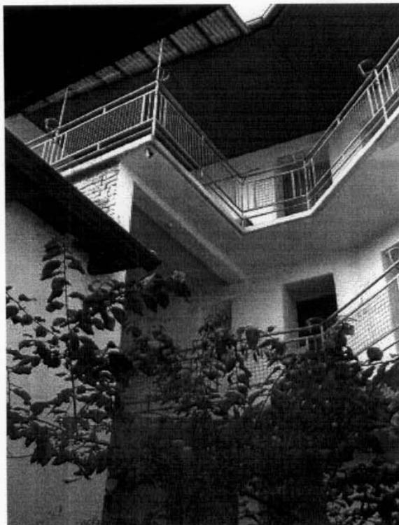
Per quanto riguarda, poi, il fabbricato a Gravellona Toce, loc. Cantonaccio, esso ha struttura in elevazione in c.a., so-lai a struttura mista in c.a. e laterizio, murature perimetra-li esterne in laterizio, mentre quelle interne sono in lateri-zio intonacato; la copertura è a tetto piano impermeabilizza-to.
